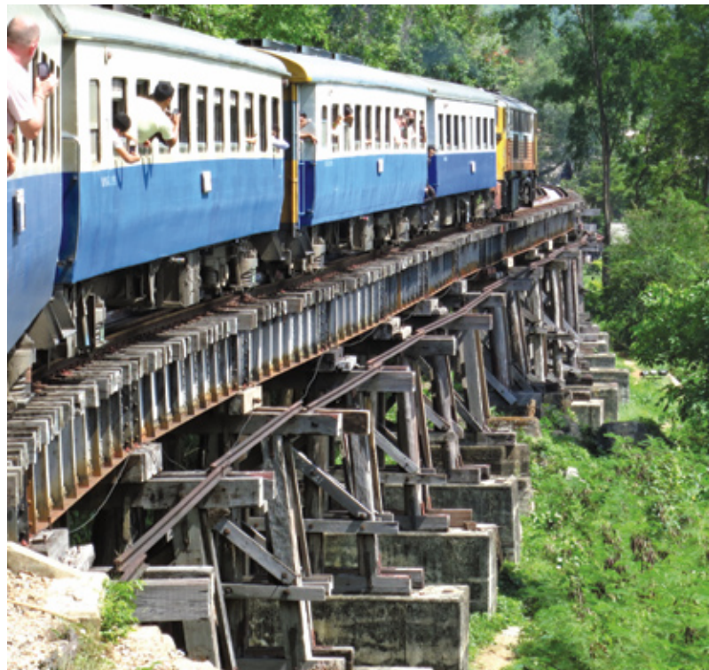
▲ Een deel van de dodenspoorlijn in Kanchanaburi is nog in gebruik.
